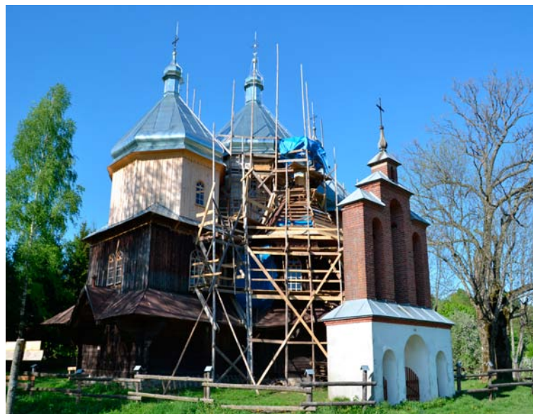
Cerkiew w Bystrem podczas prac remontowych, fot. B. Augustyn, 2015 r.
