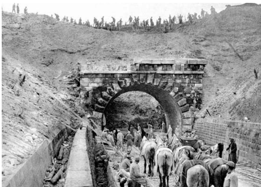
Łupków 1915 r., odbudowa tunelu
