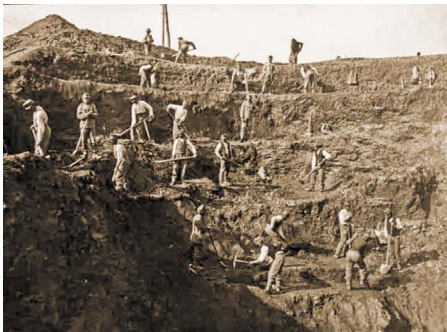
Łupków, odbudowa tunelu po zniszczeniach w I wojnie
